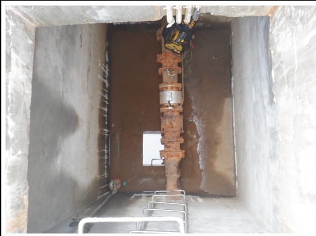
유량계실 바닥슬래브 채수
