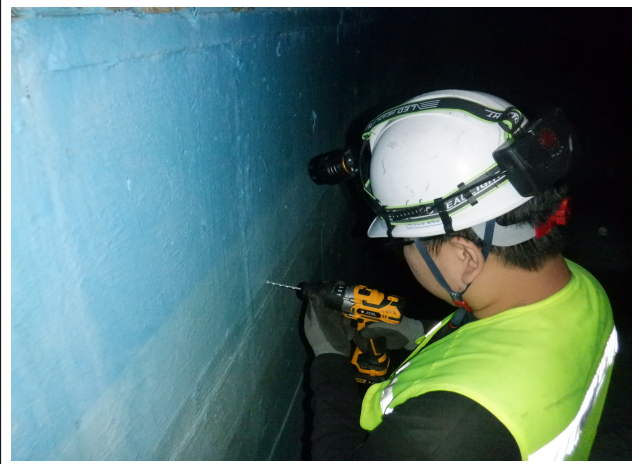
탄산화 깊이 측정
