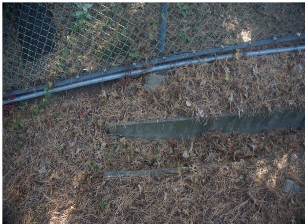
배수로 이물질 퇴적
