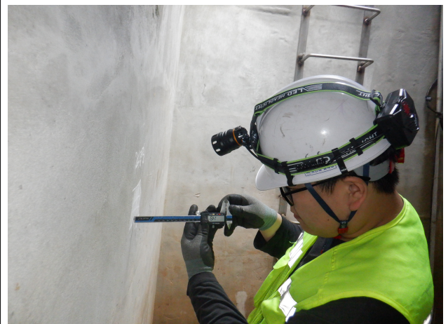
탄산화 깊이 측정
