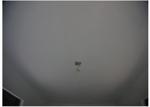
검수실 내부 보수 완료 현황
